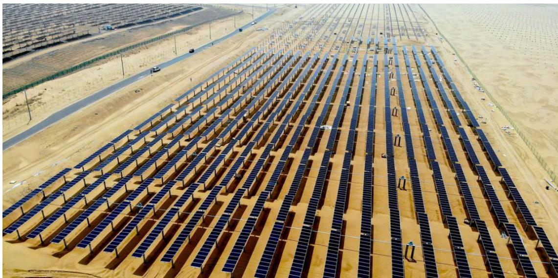
中建中环达拉特光伏发电领跑奖励基地 100MWp 1 号项目 EPC 总承包工程（二标段）项目位于我国第七大沙漠-库布齐沙漠，这里沙尘暴及大风天气频繁，地势起伏较大、植被稀少。结合活动沙丘的地貌特征，该项目基地光伏电站采用“林光互补”建设模式，在基地外围栽植沙障，主干道两侧打造防护绿化带，光伏阵列之间实施密植适宜本地生长的矮化经济林，在光伏板下方和阵列间空隙种植耐阴性沙生灌草植物或喜阴经济植物，可以有效的起到防风固沙的作用，进而使得当地的沙尘暴等灾害性天气的减少起到积极的作用，为该地区的荒漠化的治理起到显著的改善
